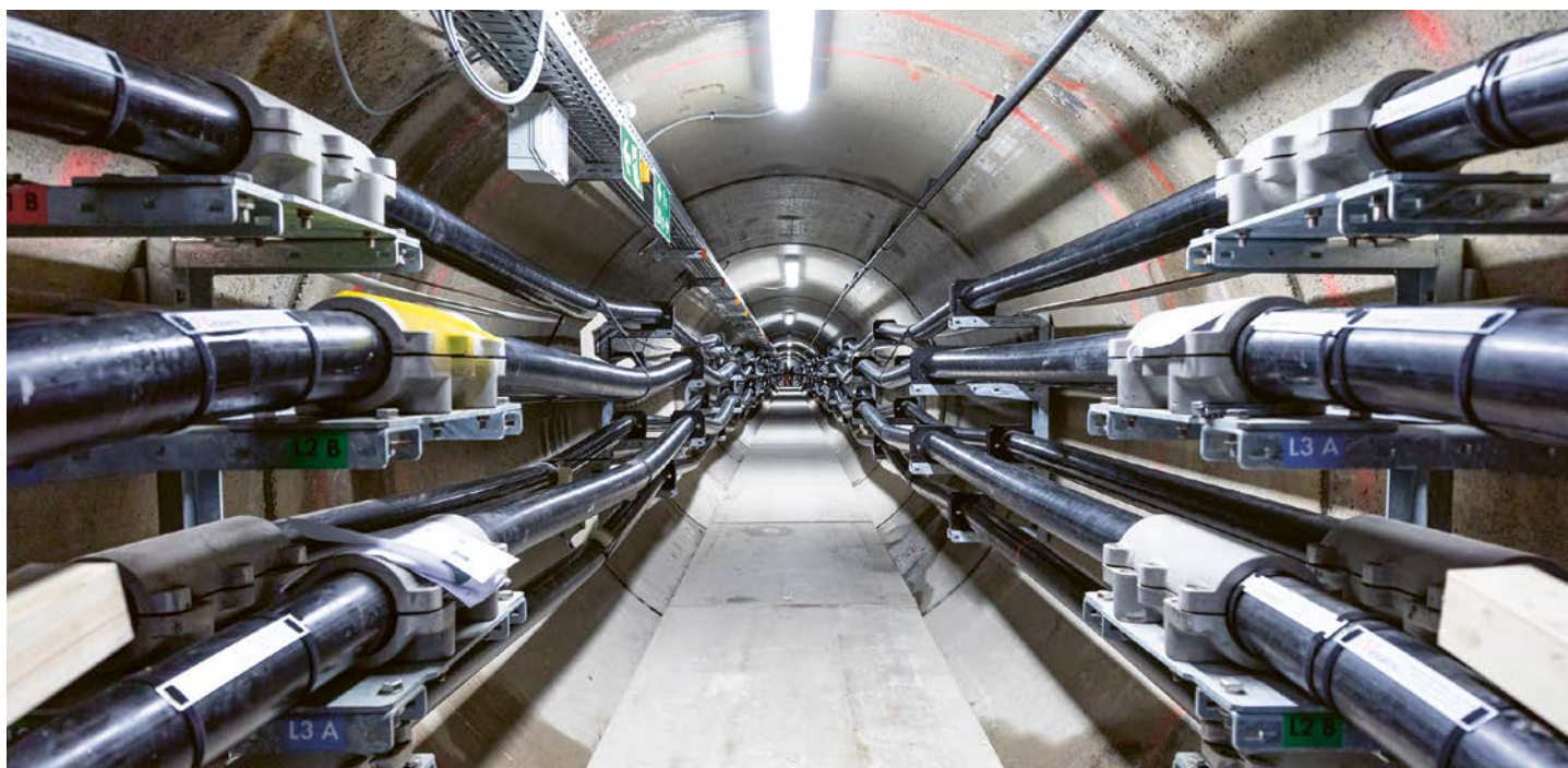
La galerie souterraine La Bâtiaz – Le Verney, mai 2022
