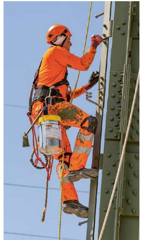
Dernier coup de peinture sur le nouveau pylône de la ligne THT Chamoson – Romanel, Le Verney, mai 2022
